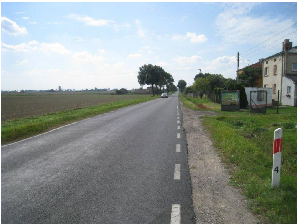
Fot. 3 Droga nr 263 w m. Krzewata
