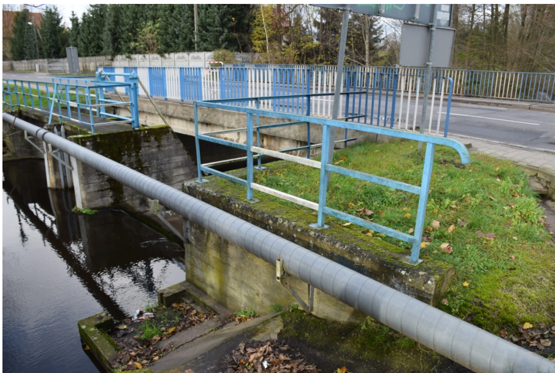
Zdjęcie nr 3 – Widok obiektu od strony południowej. Źródło: - na podstawie wizji lokalnej
