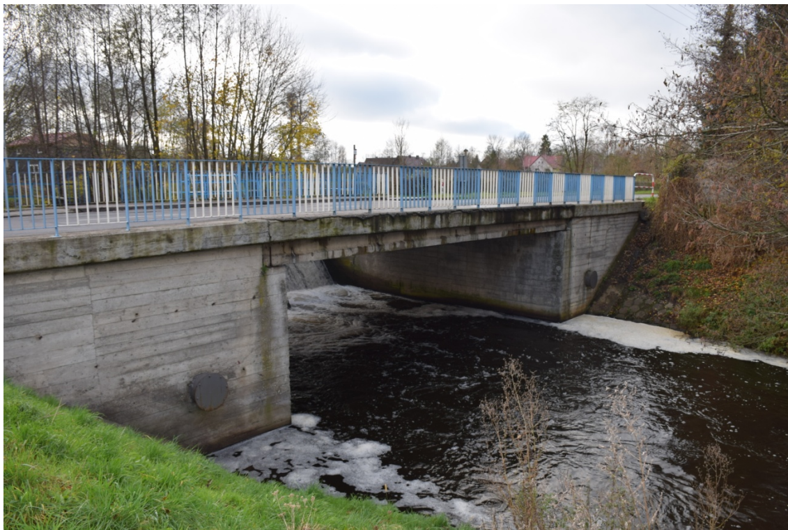
Zdjęcie nr 7 – Widok obiektu od strony północnej
