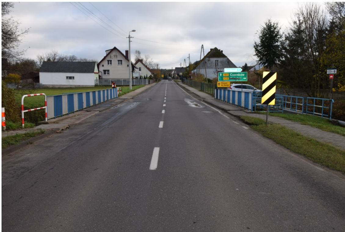
Zdjęcie nr 5 – Widok nawierzchnię obiektu w kierunku Czarnkowa Źródło: - na podstawie wizji lokalnej
