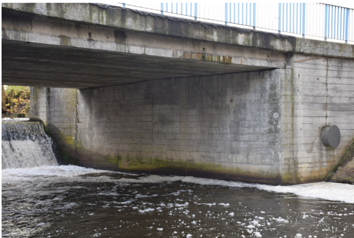
Zdjęcie nr 8 – Widok konstrukcji płyty pomostu i przyczółka od strony Drezdenka
