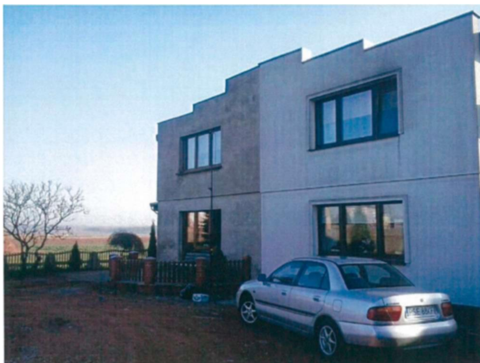
Fotografia 3 Ustawienie mikrofonu na elewacji budynku
