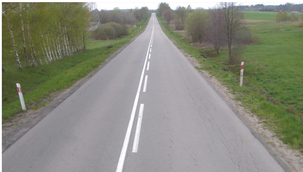
Rysunek 10: Stan dobry: skupiska spękań siatkowych zajmujące do 15% powierzchni
