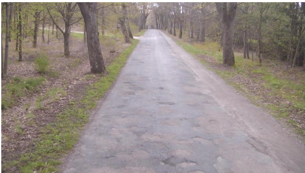
Rysunek 18: Stan zły: liczne uszkodzenia. Nawierzchnia zdegradowana
