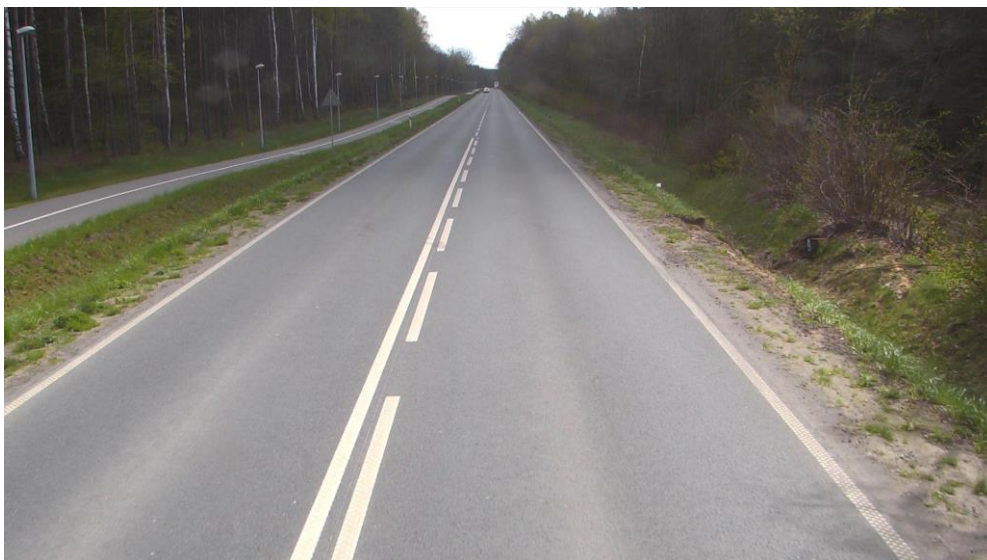
Rysunek 9: Stan dobry: brak uszkodzeń, nawierzchnia drogi jest równa
