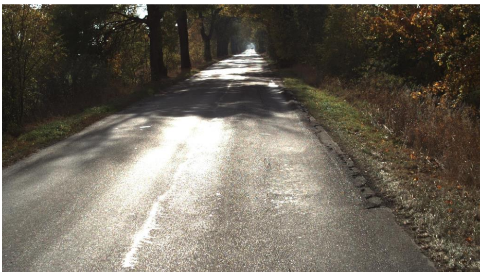
Rysunek 15: Stan ostrzegawczy: uszkodzenia krawędzi oraz widoczne koleiny
