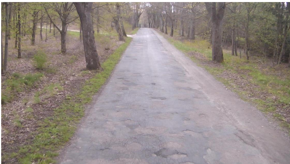
Rysunek 15: Stan zły: liczne uszkodzenia. Nawierzchnia zdegradowana
