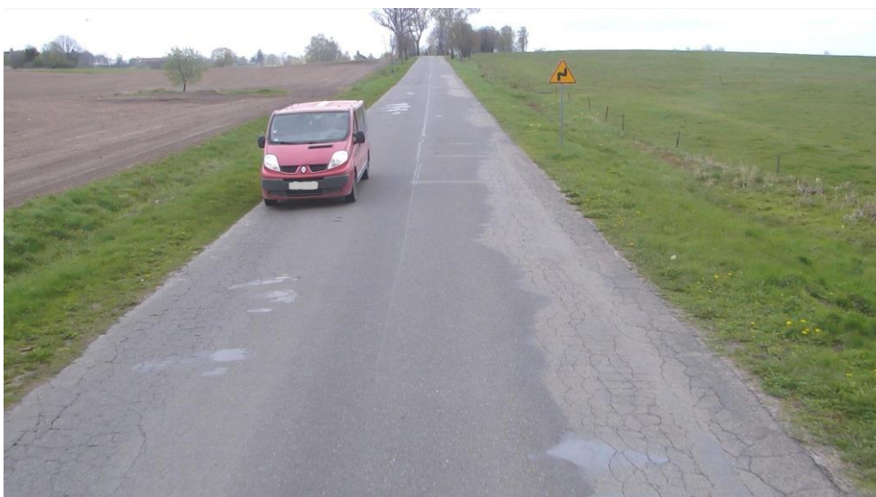
Rysunek 16: Stan zły: spękania siatkowe i skupiska spękań zajmujące ponad 30% powierzchni
